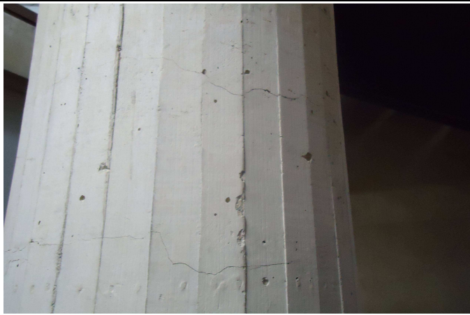
Pequeñas Fisuras Observadas en las Columnas Circulares del Centro de Documentación
