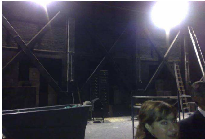
Reforzamiento Estructural Sector de la Tramoya- Tras – Escena.
