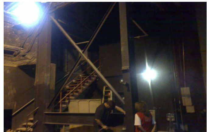
Reforzamiento Estructural Sector de la Tramoya- Tras – Escena.
