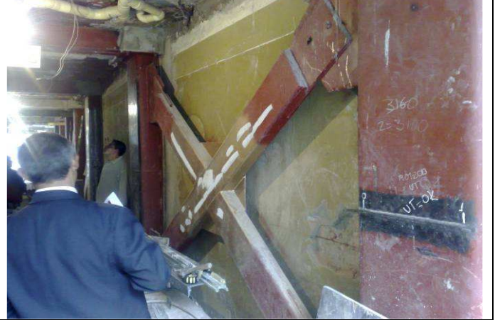
Reforzamiento Efectuado con Estructura Metálica en Muros.
