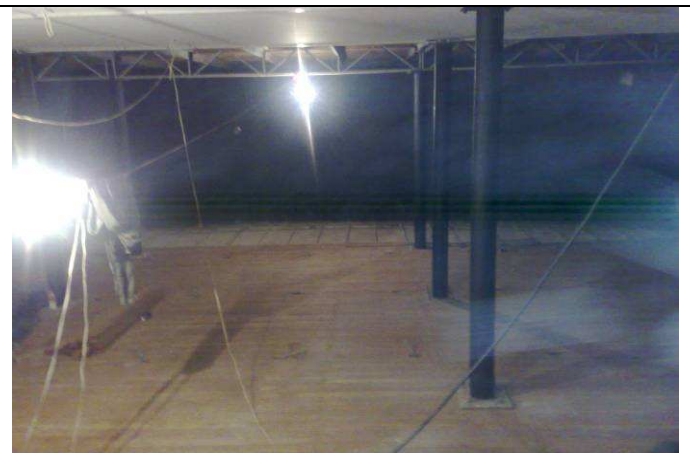
Reforzamiento Estructural CAISSON-Estructura de Reforzamiento Parte Inferior Escenario.
