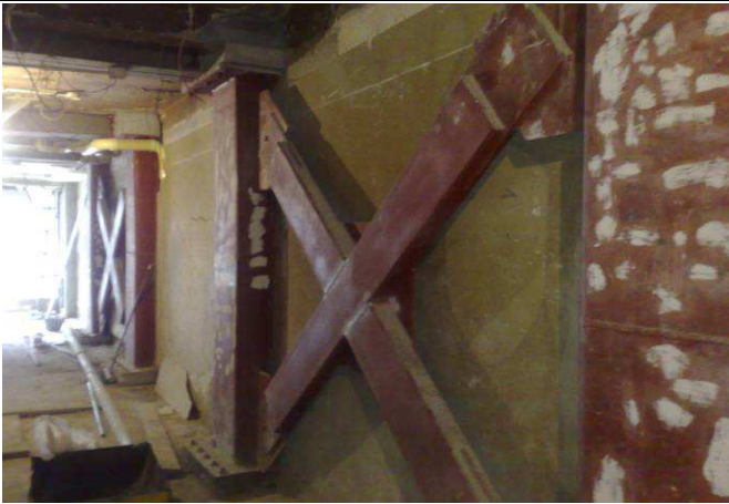
Reforzamiento Estructural Muros – Instalación pisos.
