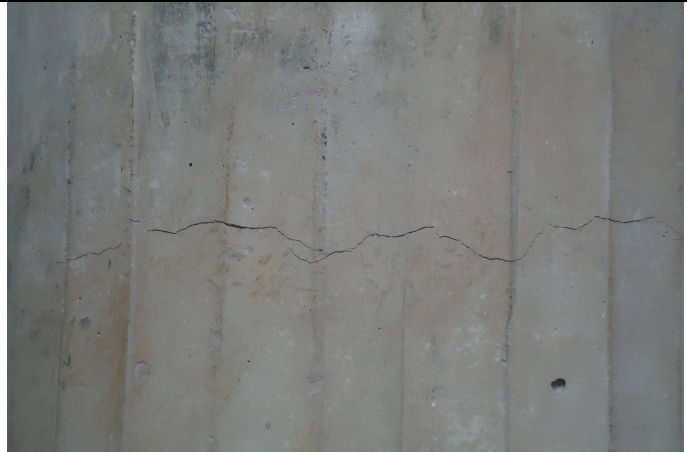
Pequeñas Fisuras Observadas en las Columnas Circulares del Centro de Documentación
