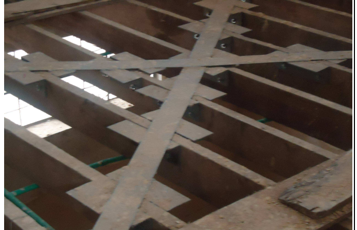
Estructura para Instalación de Pisos-Reforzamiento Vigas Principales Entrepiso
