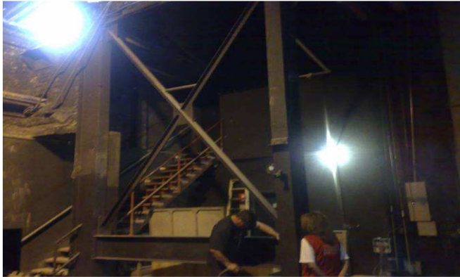
Reforzamiento en Estructura Metálica Sector Escenario
