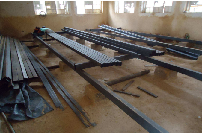
Estructura para Instalación de Pisos-Reforzamiento Vigas Principales Entrepiso
